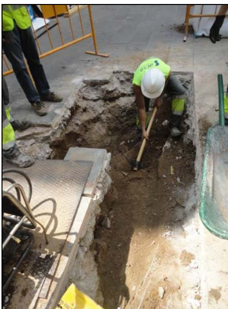
Treballs de rebaix mecànic de la Rasa 100
